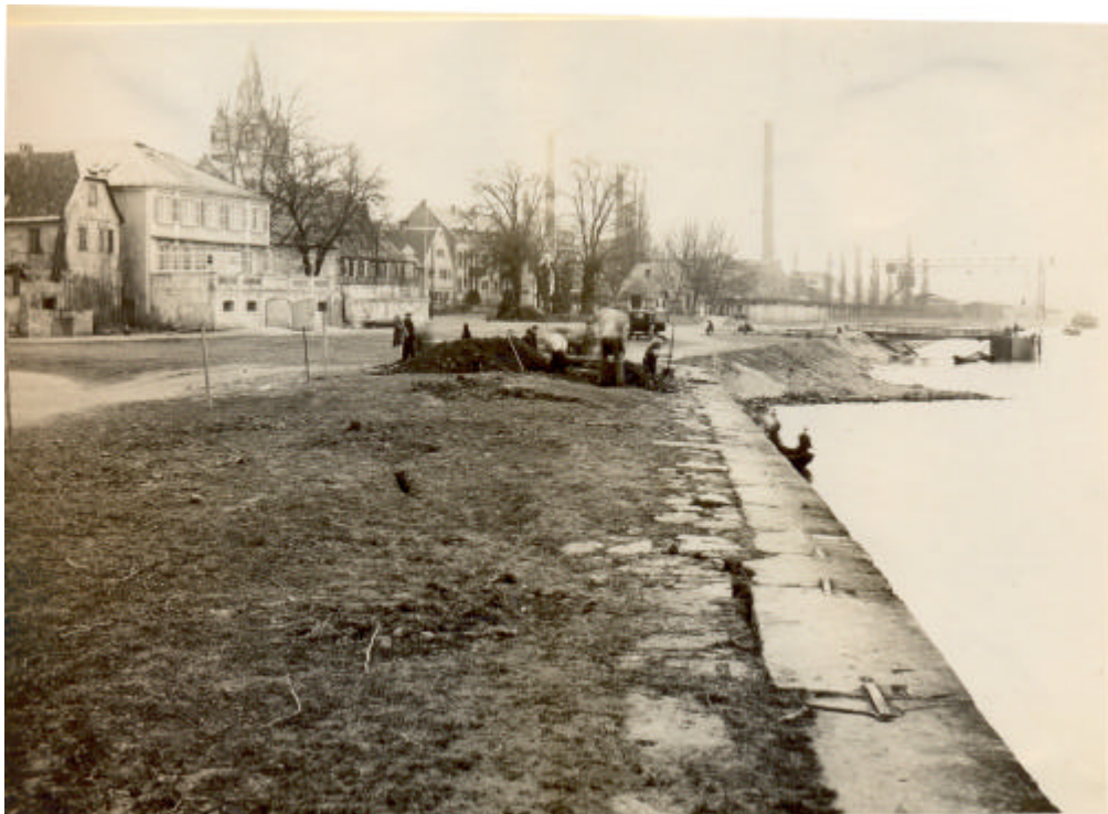
Sicherungsarbeiten an der Kaimauer 1929
