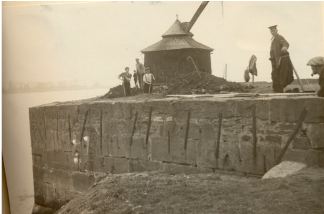
Sicherungsarbeiten am Kran 1929
