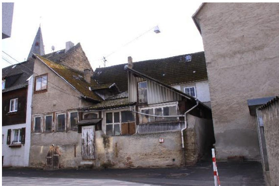
Hoher Sanierungsbedarf in der Zangerstraße
